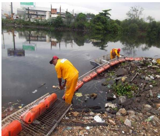
Figura 8: Exemplo de manutenção das ecobarreiras
